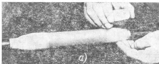
Рис. 7.74. Восстановление полиэтиленовой оболочки
